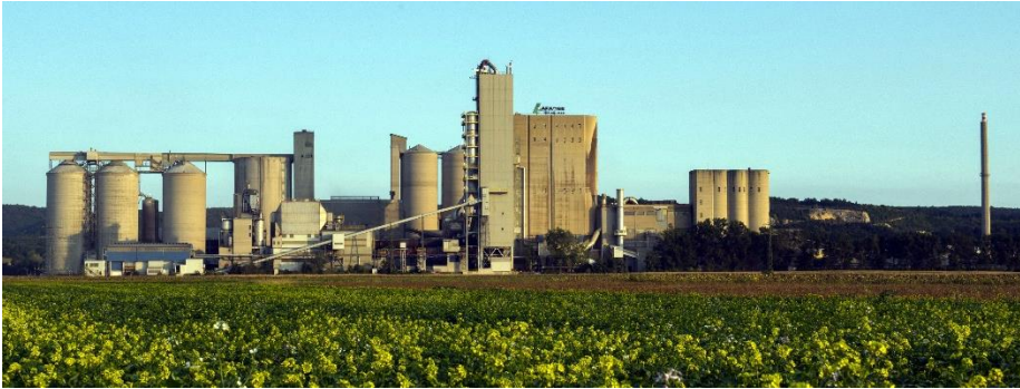
Цементный завод Lafarge в Маннерсдорфе, Австрия
