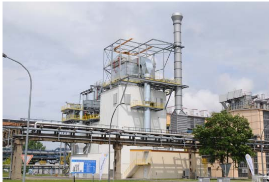
在德国 Schwarze Pumpe 电厂正在运行的莱歇磨机 LM 35.3 D
