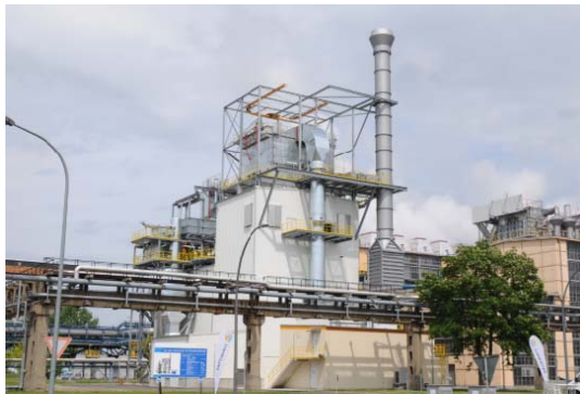
En la central eléctrica Schwarze Pumpe, en Alemania, hay un molino LOESCHE tipo LM 35.3 D en funcionamiento.
