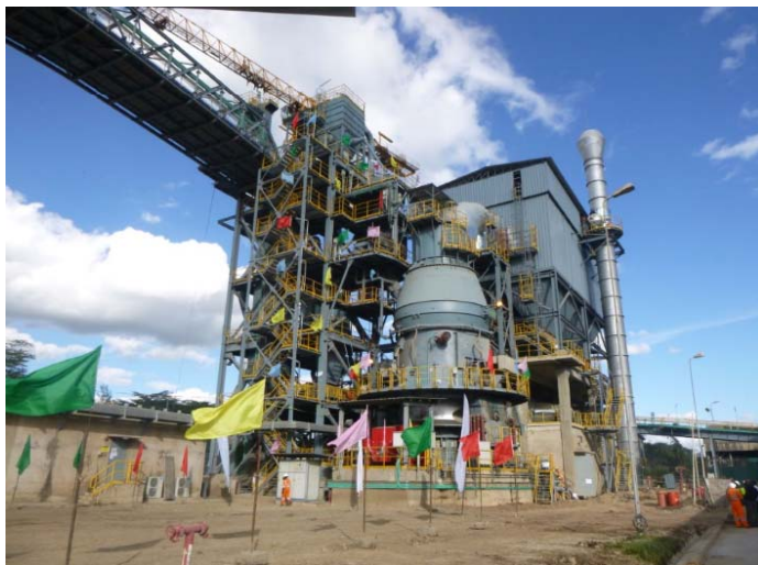
Una de los probados molinos LOESCHE para la molienda de clínquer y escoria en Africa
