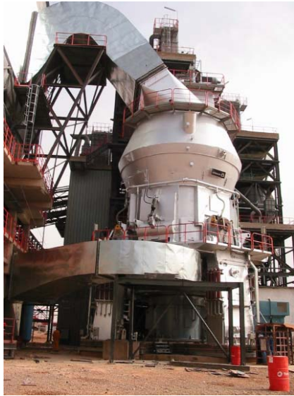
Foto einer LOESCHE Mühle Type LM 56.3+3 CS in einem Zementwerk in Settat, Marokko
