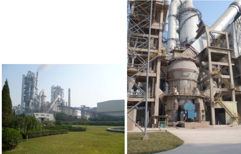
Molino LOESCHE similar al tipo LM 56.4 en la fábrica de cemento Jurong, China
