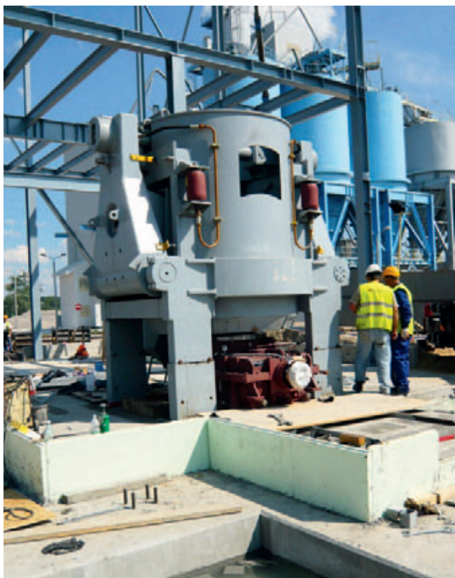
Строительство мельницы Loesche типа LM 15.200.
